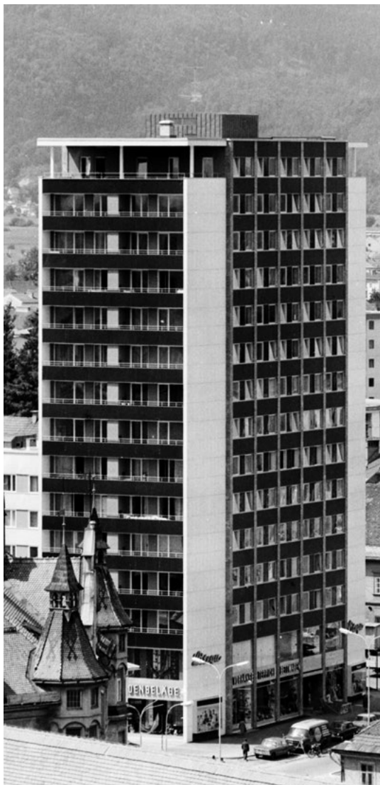
Das kürzlich sanierte Rothauer-Hochhaus im Zentrum von Klagenfurt in den 1970er-Jahren.
